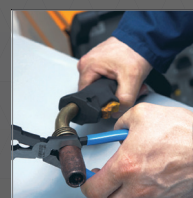
demontaż i instalacja dyszy
